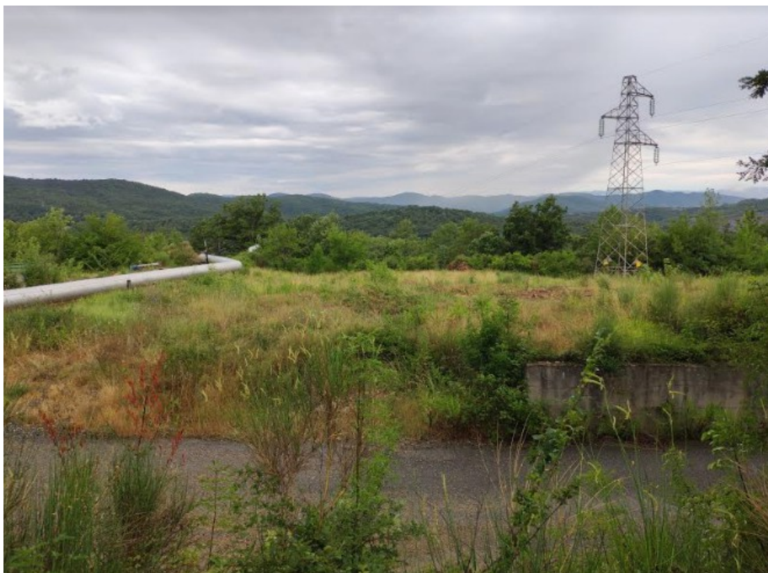
vista lato ovest
